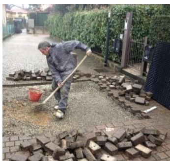
1. Rimozione della pavimentazione esistente
