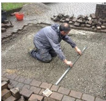
2. Preparazione del piano di posa
