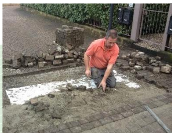
5. Posa degli autobloccanti
