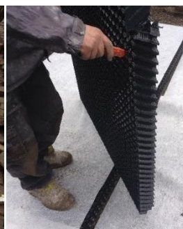
4. Taglio dei pannelli
