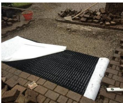
3. Posa dei pannelli drenanti
