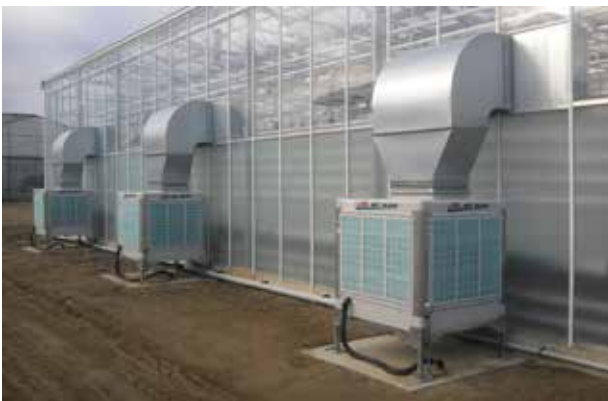
Instalación AD- 15-VS en invernadero
