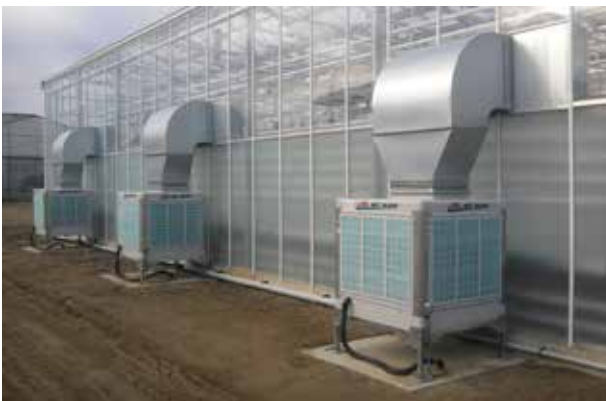
Instalación AD- 15-VS en invernadero
